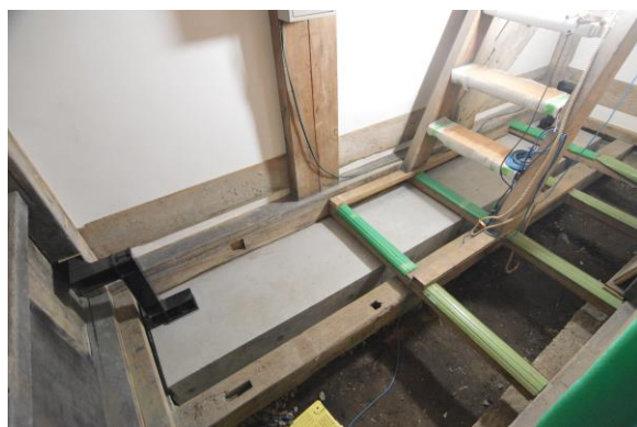
城門土台下の耐震補強〔三の丸追手門1階〕
