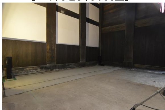
耐震補強完了〔三の丸追手門東内壁〕
