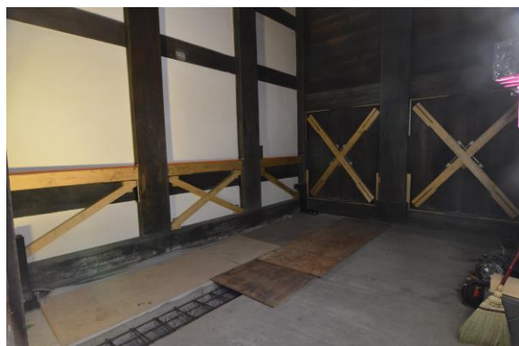
筋違いとおもりを追加 〔三の丸追手門東内壁〕
