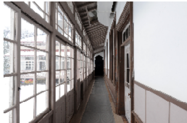
写真10 「南面廊下(廊下3)」 西を見る
