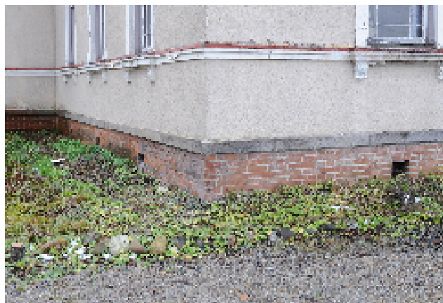
写真 12 外廻り地盤の状況 「小集会所」部分
