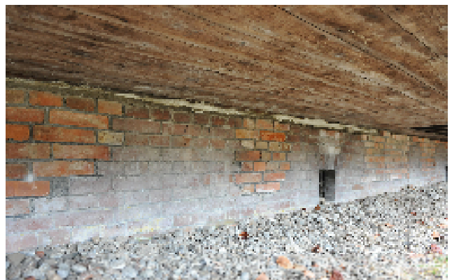
写真 23 南面煉瓦積基礎の積み直し状況
