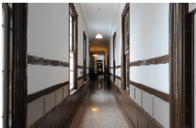
写真9 「北面廊下(廊下1)」 東を見る
