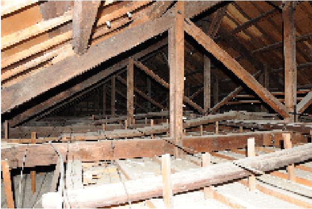
写真 28 小屋組の状況 東を見る
