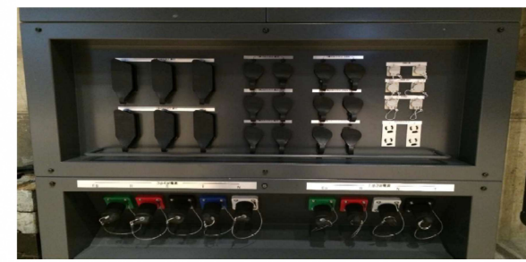
持込照明機器電源盤 (上手 x 1・下手 x 1)
